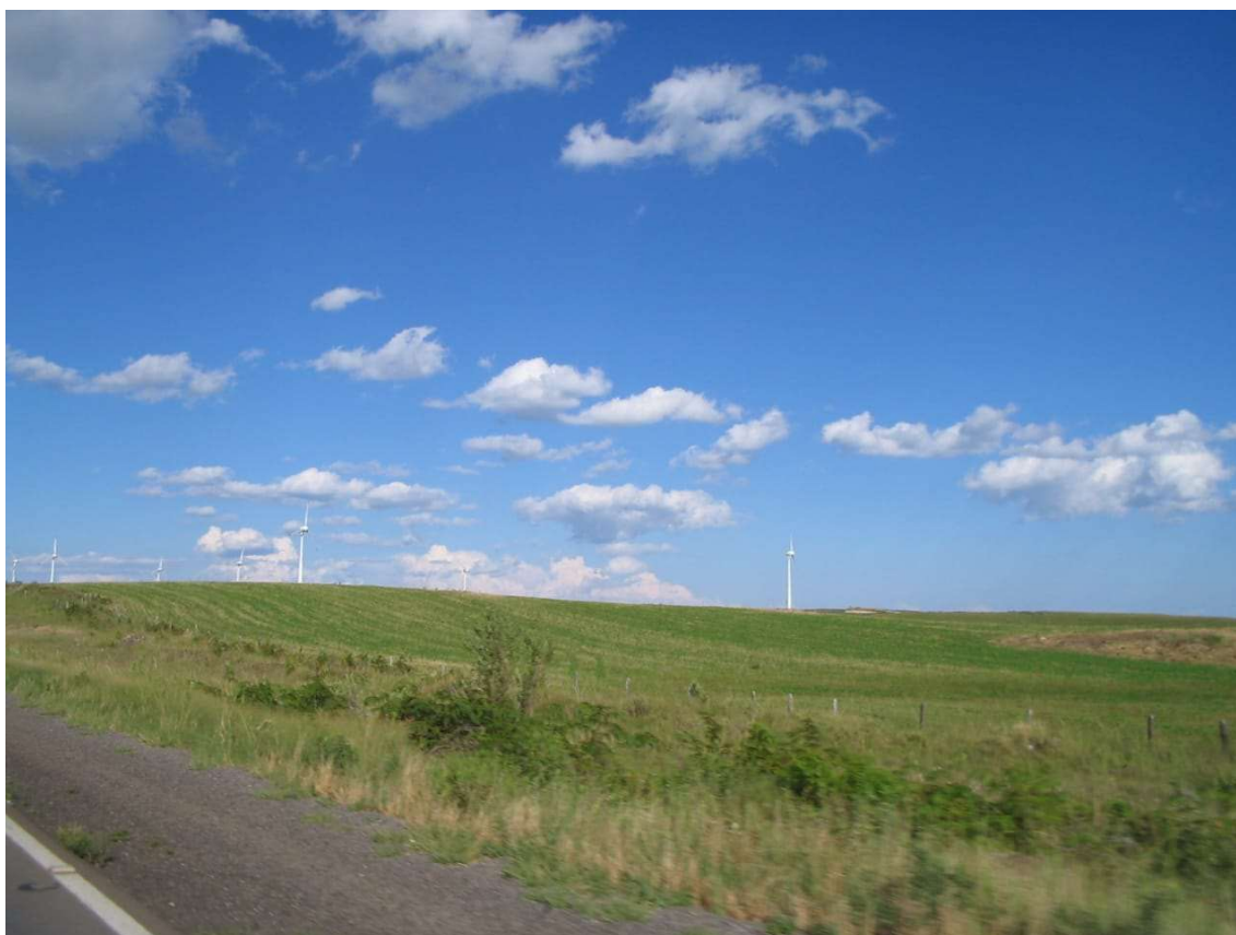
Figura 118. Vista das usinas eólicas instaladas em Água Doce, na MR de Joaçaba
