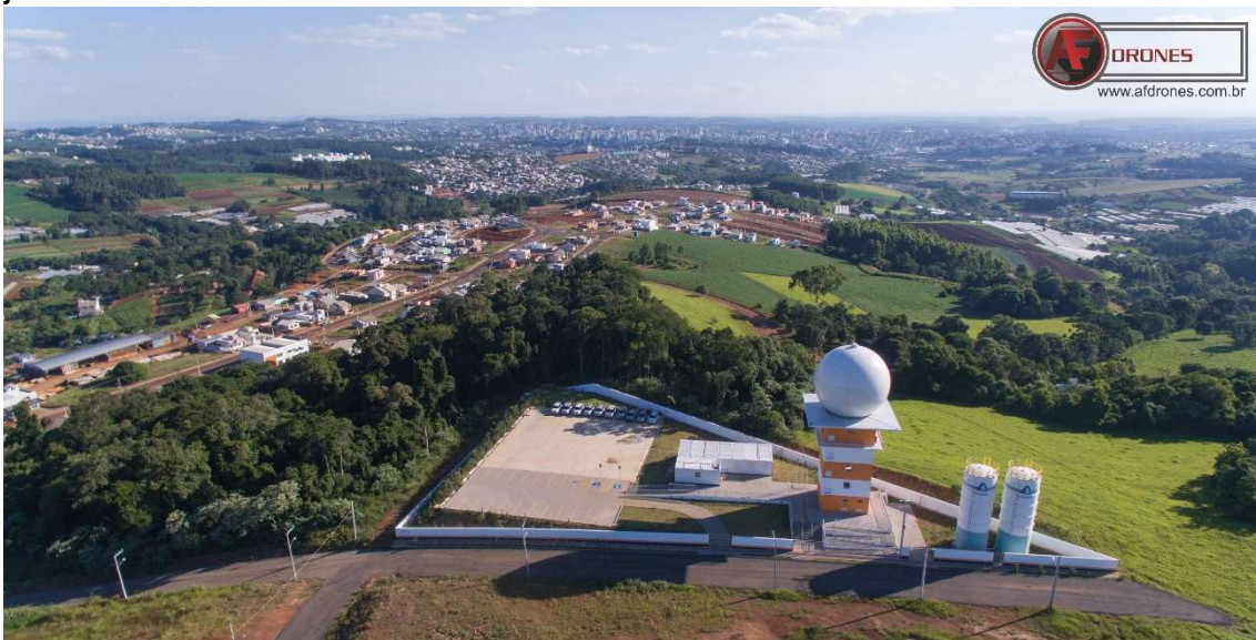
Figura 144. Área de expansão urbana e áreas de cultivo agrícola: Bairro Desbravador em Chapecó, junto à divisa com Xaxim
