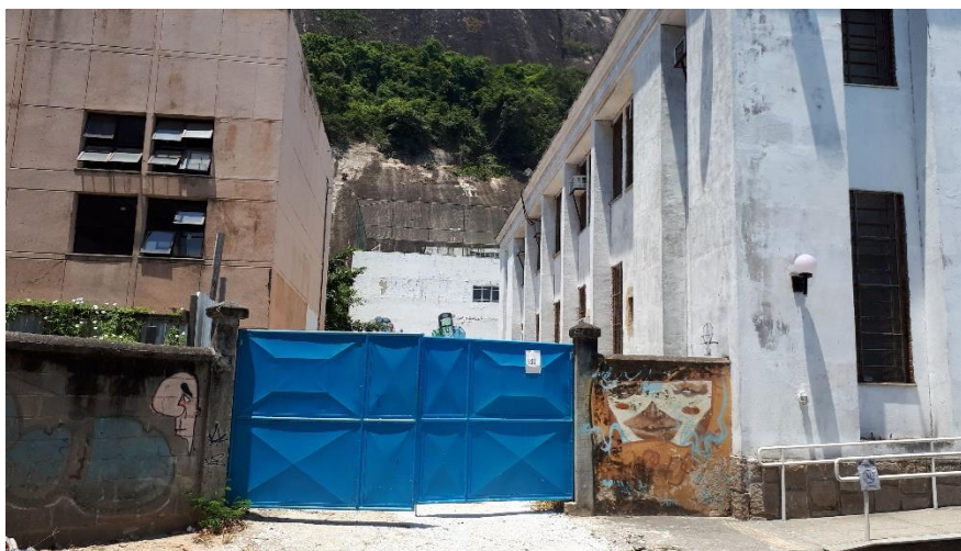
Figura 64 – Portão de serviço
