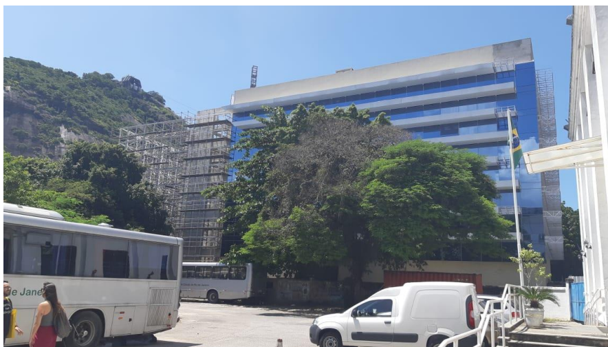
Figura 24 – Edifício da futura sede do CCH, UNIRIO
