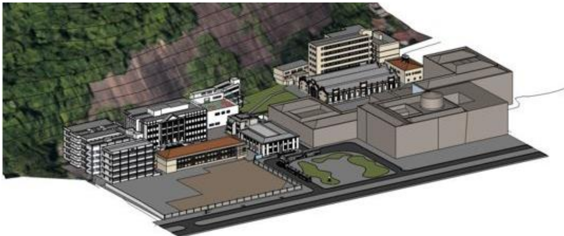
Figura 36 – Acréscimo do Edifício Restaurante Escola (2012)
