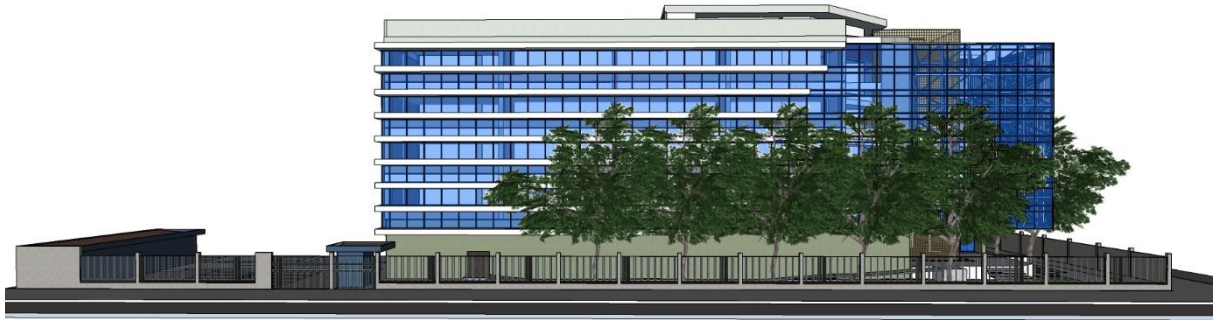
Figura 96 – Fachada Pasteur – Vista Geral
