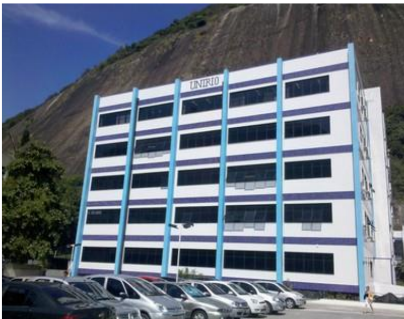
Figura 22 – Edifício do CCET/BIO, UNIRIO
