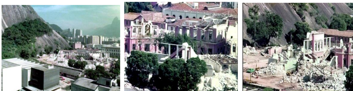
Figura 17 – Série mostrando a demolição do edifício da Faculdade Nacional de Medicina
