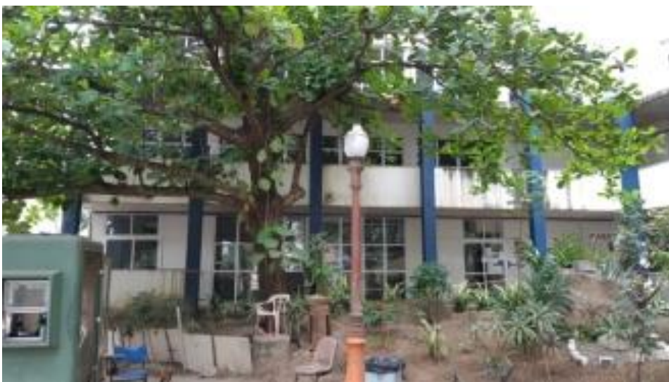
Figura 23 – Edifício do Restaurante Escola, UNIRIO
