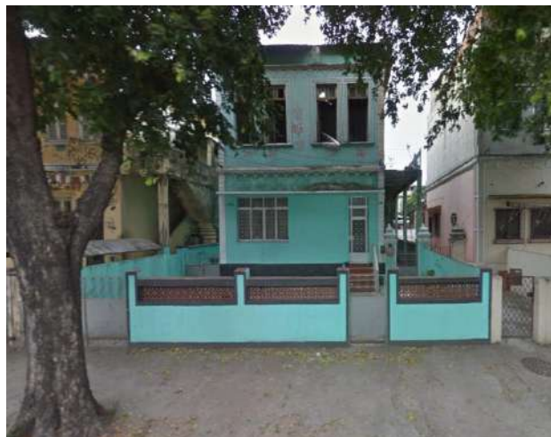
Figura 50 - Edificação nº 1733 da Rua João Vicente
