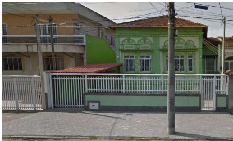
Figura 47 - Edificação nº 630 da Av. Eng. Assis Ribeiro
