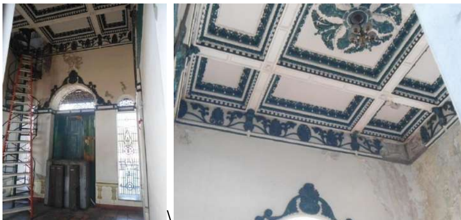
Figura 28 - Interior da Estação Ferroviária
