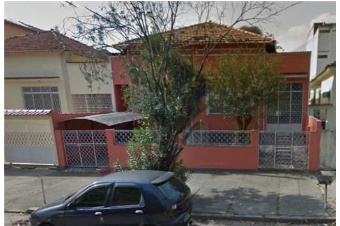
Pintura com tons fortes, destoando do conjunto.
