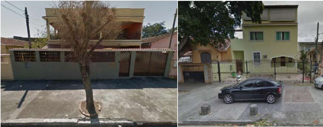
Figura 49 - Edificações nº 118 e nº 446 da Av. Engº. Emílio Baumgart
