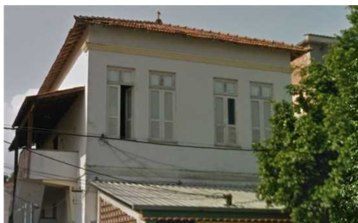
Fiações e instalações aparentes nas fachadas, interferindo no imóvel preservado.
