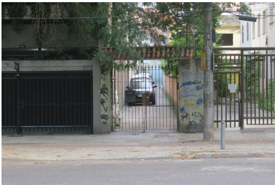
Figura 39: Entrada de vila, Rua das Laranjeiras nº 285
