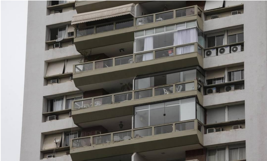
Figura 3: Fechamento de varandas em condomínio da Barra da Tijuca
