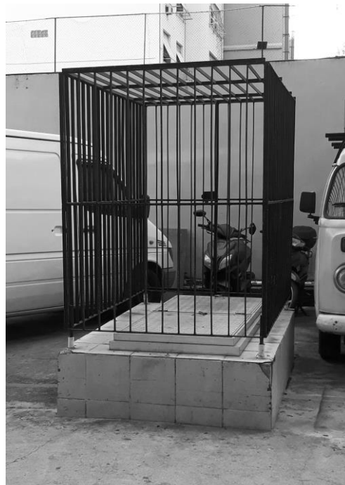
Figura 5 - Rua das Laranjeiras, nº 336: Fechamento em serralheria sobre cisterna
