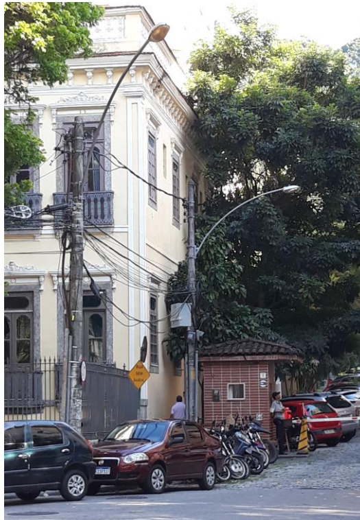
Figura 16: Rua das Laranjeiras, esquina com Rua Ribeiro de Almeida: guarita para controle de acesso construída sobre a via.
