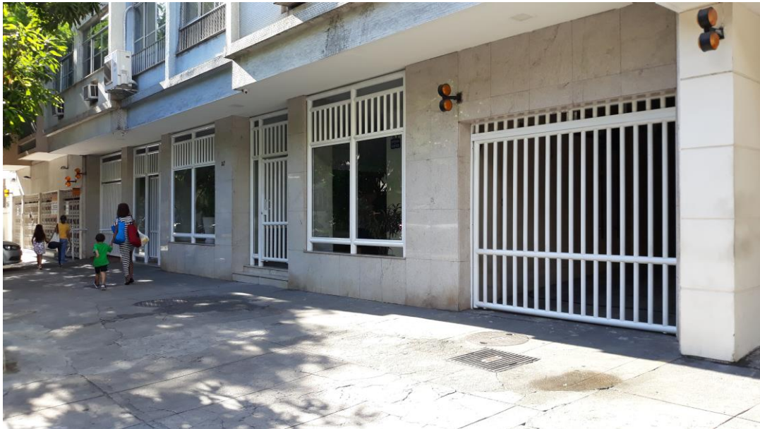
Figura 18: Rua das Laranjeiras 247 - fechamento do térreo revestido em granito em contraste com o resto da fachada, de período anterior, revestido em pastilha de porcelana.
