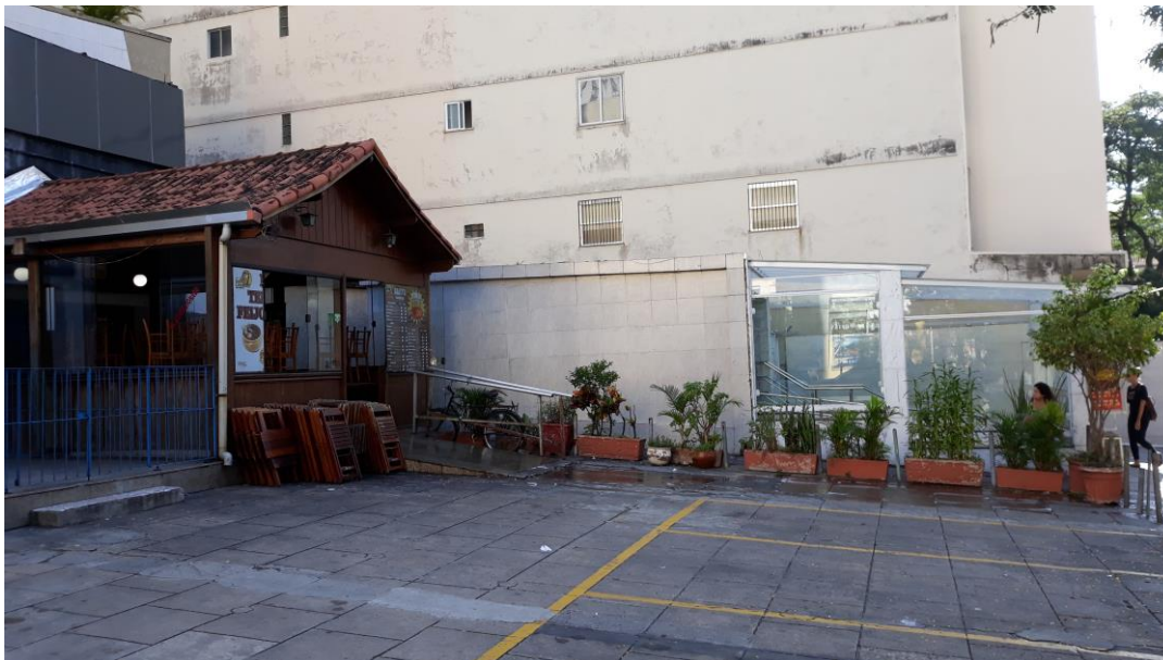
Figura 15: Rua das Laranjeiras, 336 – acréscimo feito por uma das unidades (telhado pertencente à loja) e pelo condomínio (cobertura para acesso as unidades residenciais).
