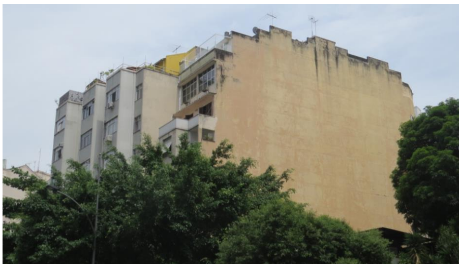
Figura 43: Cobertura do imóvel Rua das Laranjeiras 218
