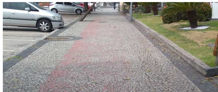
Figura 31: Pavimentação da faixa compartilhada da praça inominada na Estrada do Galeão, apresentando problemas na manutenção da tintura sobre pedra portuguesa.
