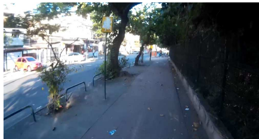
Figura 43: Placa vandalizada na infraestrutura cicloviária do Rio Jequiá.
