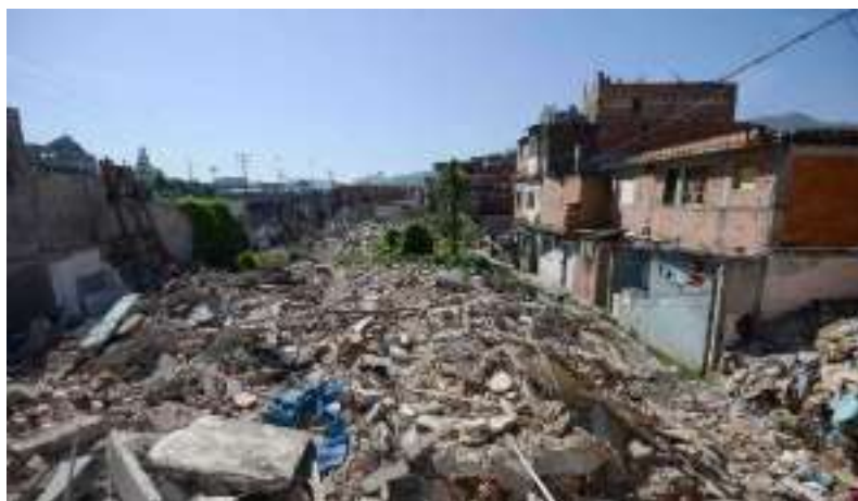
Figura 23: Área de casas demolidas da Favela do Metrô, na comunidade da Mangueira.
