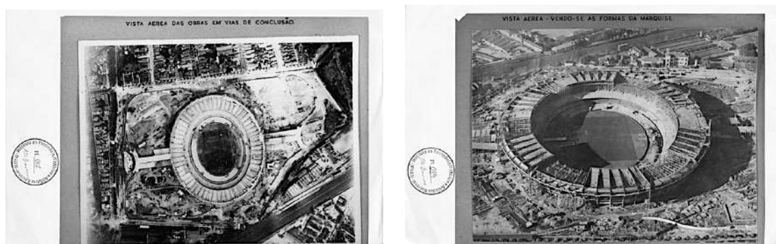
Figura 10: Vista aérea das obras em vias de conclusão
