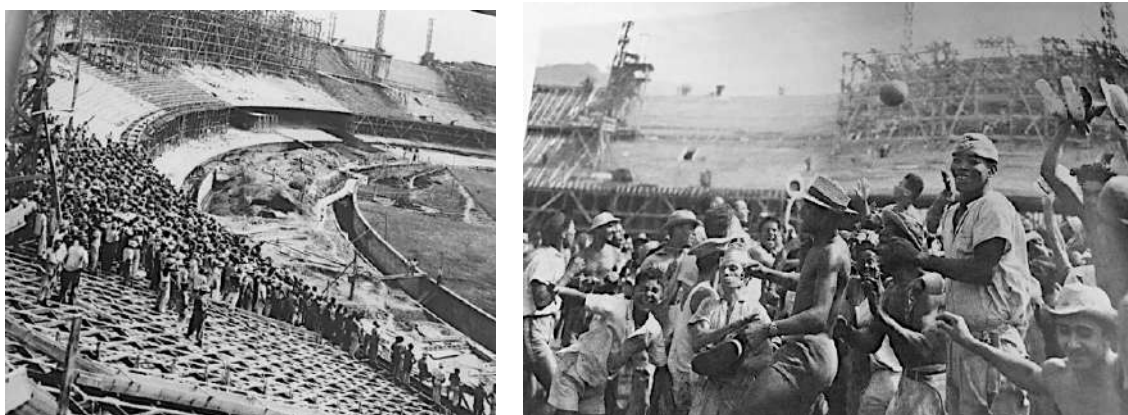
Figura 11: Operários comemoram a finalização de uma etapa da obra e teste de peso da arquibancada
