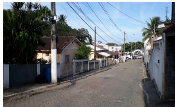
Calçadas estreitas, sem rebaixamento de rampas, e desniveladas
