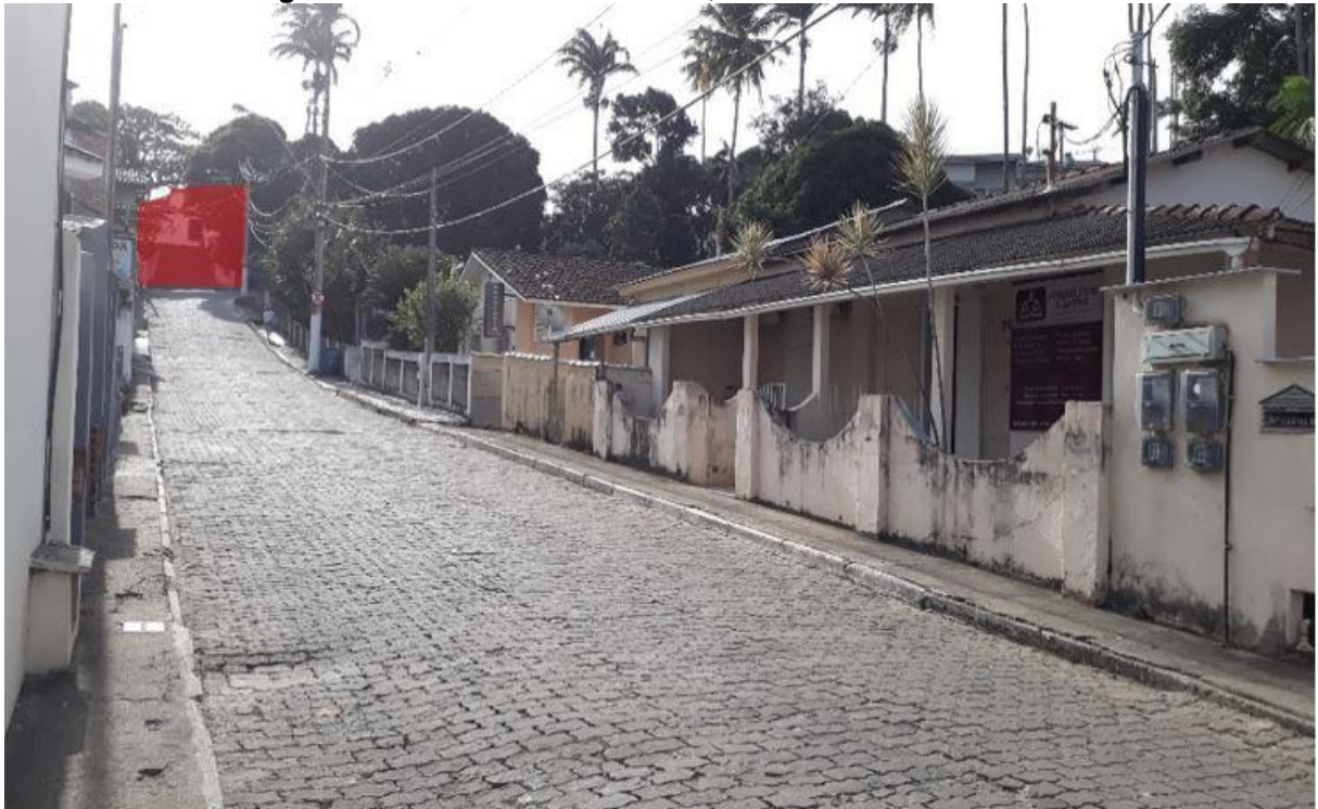
Figura 17: Vista 4 da fachada leste, lateral direita do Santuário.
