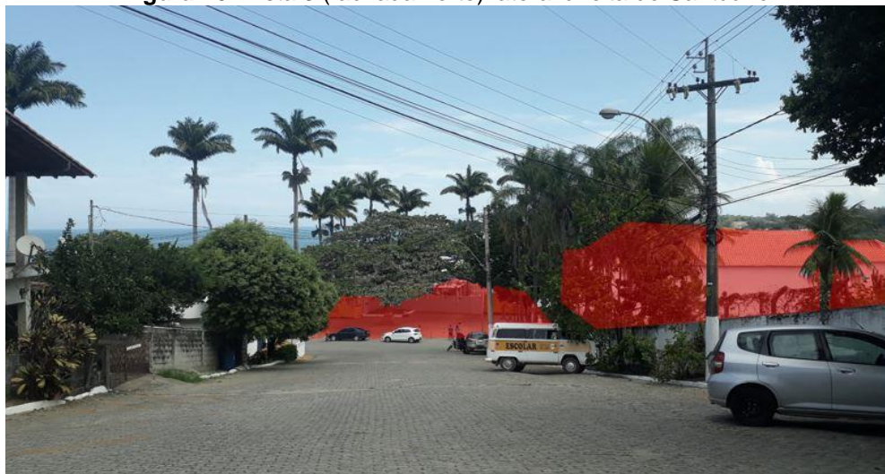
Figura 16: Vista 3 (fachada norte) lateral direita do Santuário.
