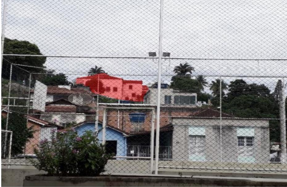
Figura 15: Vista 2 (fundos), fachada oeste do Santuário. É possível ver a falta do controle construtivo no entorno do monumento.
