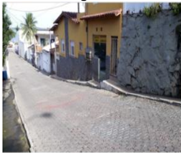
Falta de nivelamento entre as calçadas
