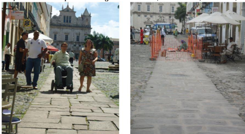
Figura 74: Figura da esquerda: Passarela antes da intervenção. Figura da direita: Passarela rejuntada após a intervenção. No Largo do Cruzeiro, Pelourinho, Salvador, BA, 2018.
