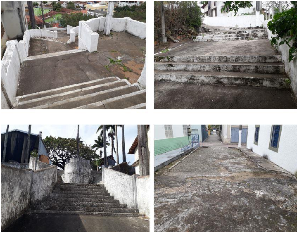
Figura 89: Vista da escadaria 02 de acesso ao Santuário.
